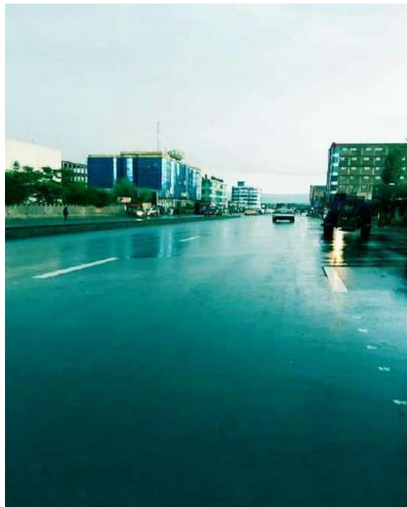
تصویر 4: نمای سرک جدیداً احداث شده در شهر خوست
